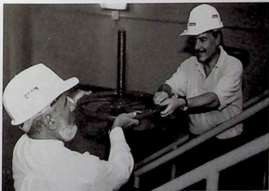
El presidente de la República, Andrés Pastrana Arango, y el sacerdote Bernardo Hoyos, Alcalde de Barranquilla, abren la válvula de la estación depuradora de aguas residuales, la cual beneficia a 350 mil personas quienes esperaron la obra durante 40 años. Barranquilla, 25 de agosto de 1999.
