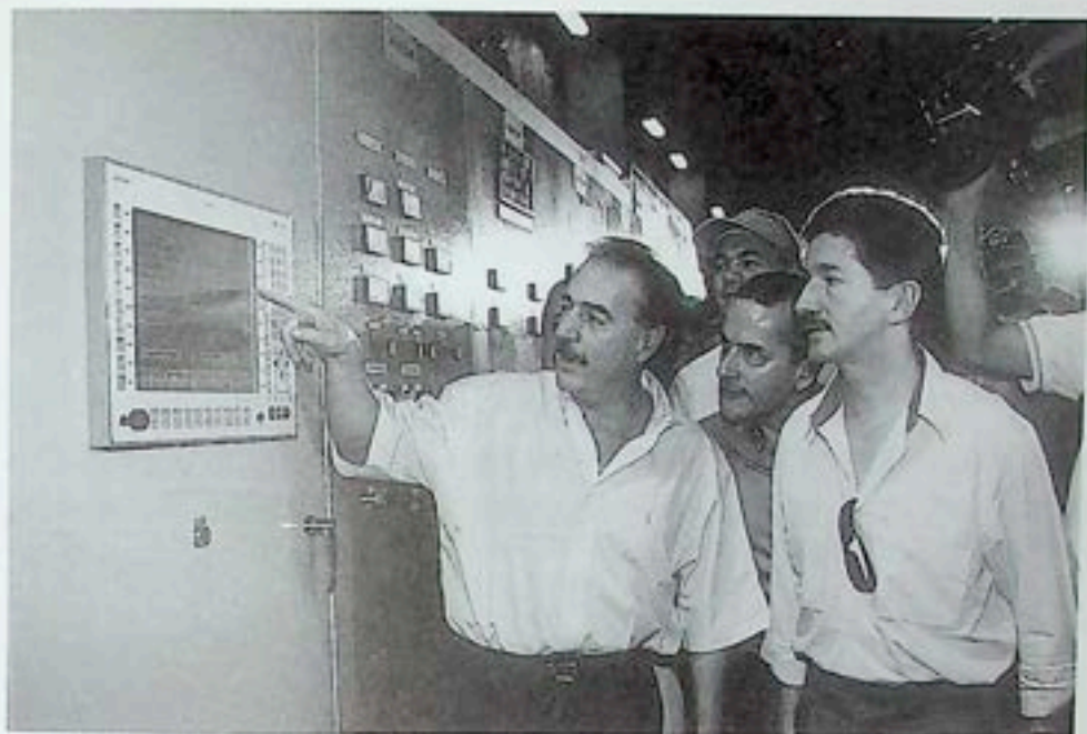
El presidente de la República, Andrés Pastrana Arango, fue el encargado de encender la primera turbina de la nueva Hidroeléctrica Porce II, que entrará a generar 392 megavatios el próximo mes. Porcecito, Antioquia, 9 de abril de 2001.
