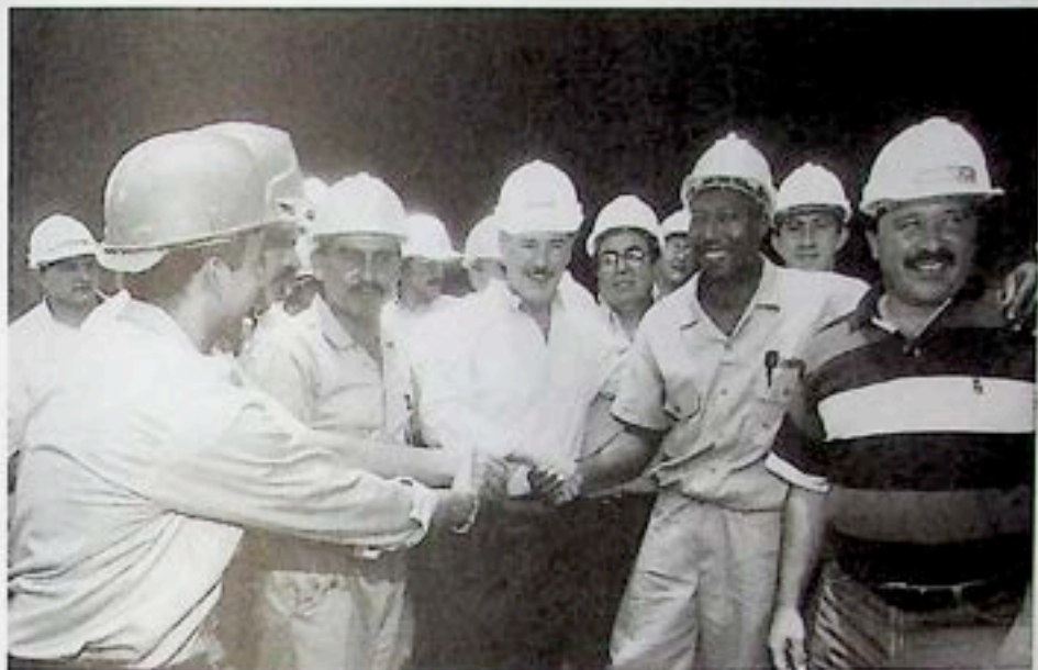
El presidente de la República, Andrés Pastrana Arango, recorrió el túnel de Buenavista en el viaducto principal de la carretera que une a Villavicencio con Bogotá. El Mandatario compartió un momento con los trabajadores que construyen esta vía. Buenavista, Meta, 1º de octubre de 1999.
